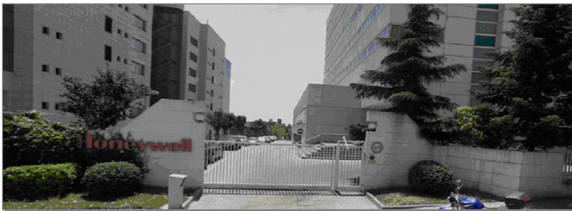
Nueva delegación de Madrid de Honeywell Life Safety Iberia. C/Josefa Valcárcel, 24. Planta 5.
